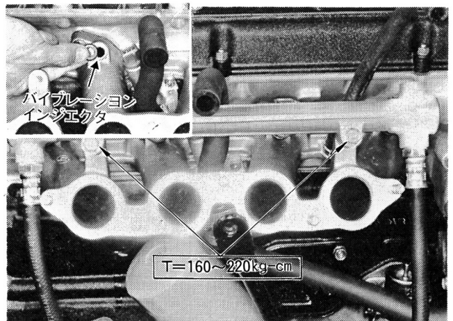
図4-35 デリバリ パイプ取り付け
